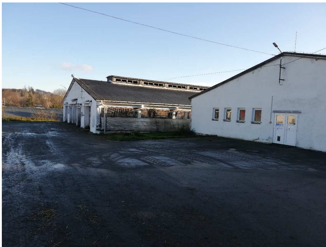
Stáj určená k demolici, v popředí ponechávaná dojírna
