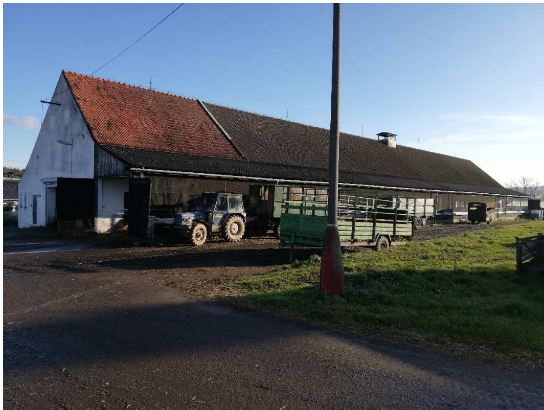
Pohled na stáj určenou k demolici
