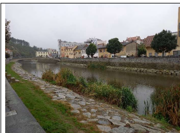
Obr. 20 Pohled po proudu na lávku Plukovníka Svobody (lavka 78) a PPO, ř. km 92,70
