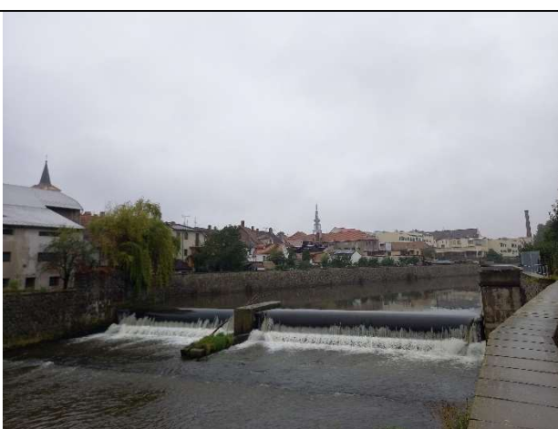
Obr. 23 Pohled proti proudu na vakový jez nad Smetanovým mostem (jez 72) a PPO, ř. km 92,10
