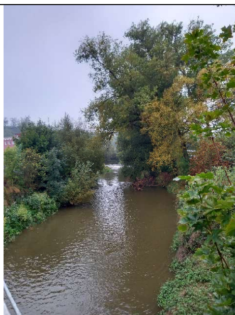
Obr. 31 Pohled proti proudu na koryto Jihlavy z mostu pro Palečkův Mlýn, ř. km 90,13
