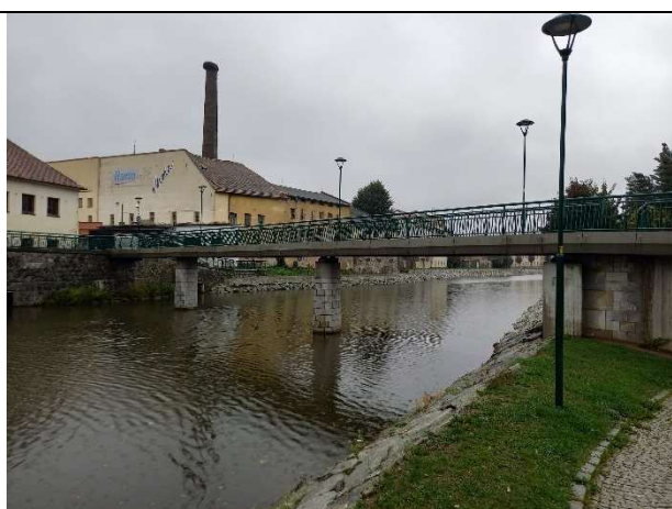
Obr. 21 Pohled proti proudu na lávku v ulici Soukenická (lavka 76), ř. km 92,35
