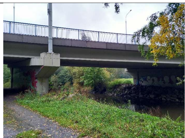
Obr. 27 Pohled proti proudu na střední část mostu na ulici Sportovní (most 57), ř. km 90,82
