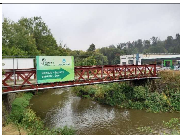
Obr. 29 Pohled po proudu na most pro Palečkův Mlýn (most 52), ř. km 90,13
