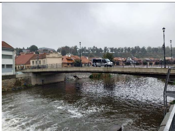
Obr. 19 Pohled po proudu na Podklášterský most (most 80), ř. km 92,96
