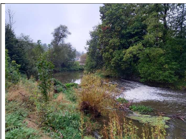
Obr. 28 Pohled proti proudu na pevný jez (jez 53), ř. km 90,25
