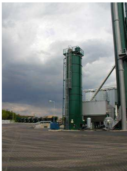
silu hnědouhelného prachu a odprašovací zařízení
