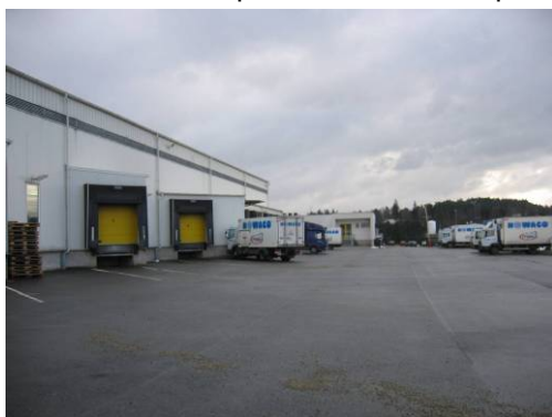
Obr. 8 Parkoviště pohled na nákl. rampu
