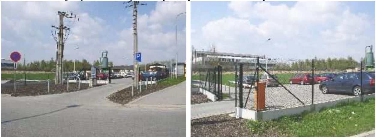
Obr. č. 11. Stávající parkoviště a plocha výstavby záměru RPH od vjezdu ze silnice č. II/353.
