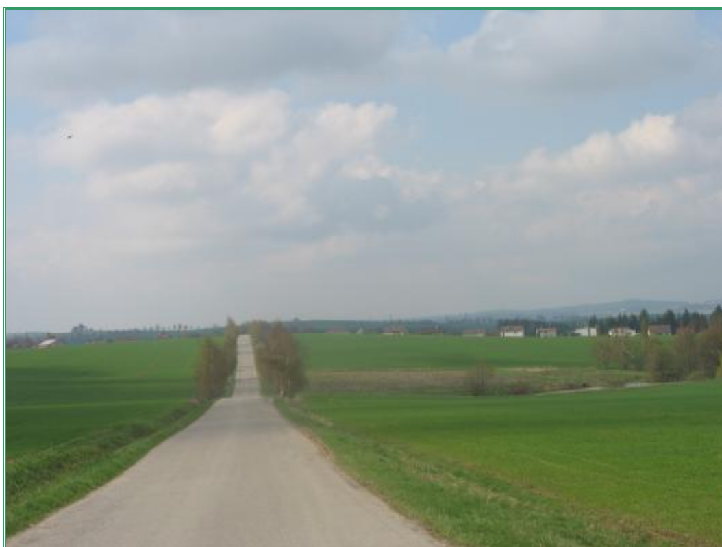
Obrázek – Příjezdní komunikace na skládku
