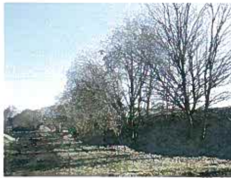
pohled východní – detail svahu
