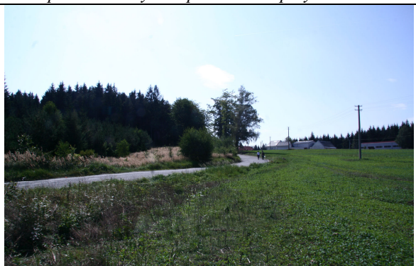
Pohled proti směru staničení do prostoru vyrovnání nevyhovujícího oblouku kolem km 0,2
