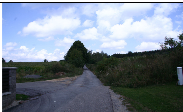
Pohled proti směru objízdné trasy severně od Zborné
