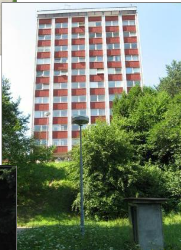
Obr. 2.: Stávající výšková budova PSJ (k rekonstrukci)
