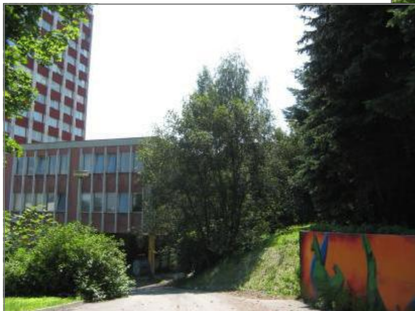
Obr. 3.: Příklad výškové budovy (k demolici)
