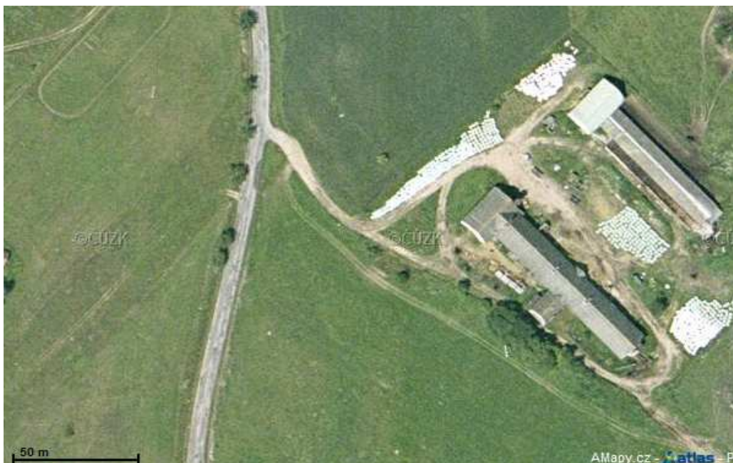
Obrázek č. 3: vzdálenost silnice II/360 a kravína
