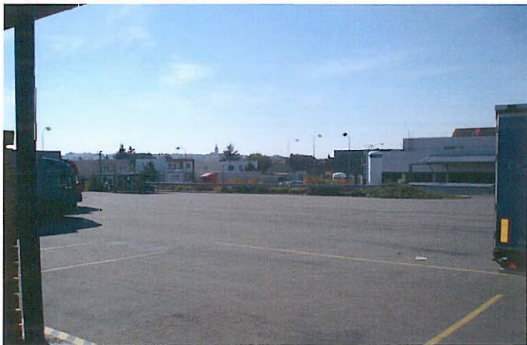
Stávající zpevněná plocha vně haly
