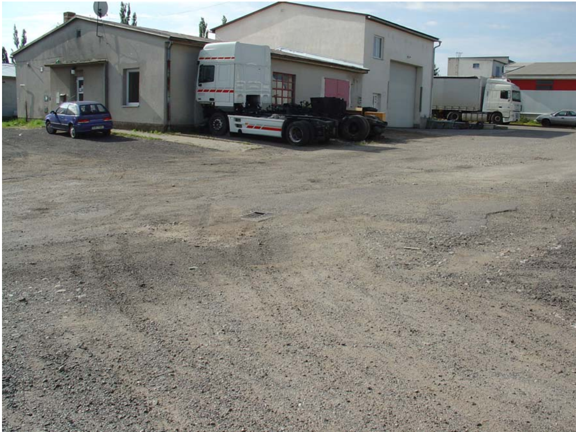
Foto 2 : Objekt dílny údržby a oprav motorových vozidel
