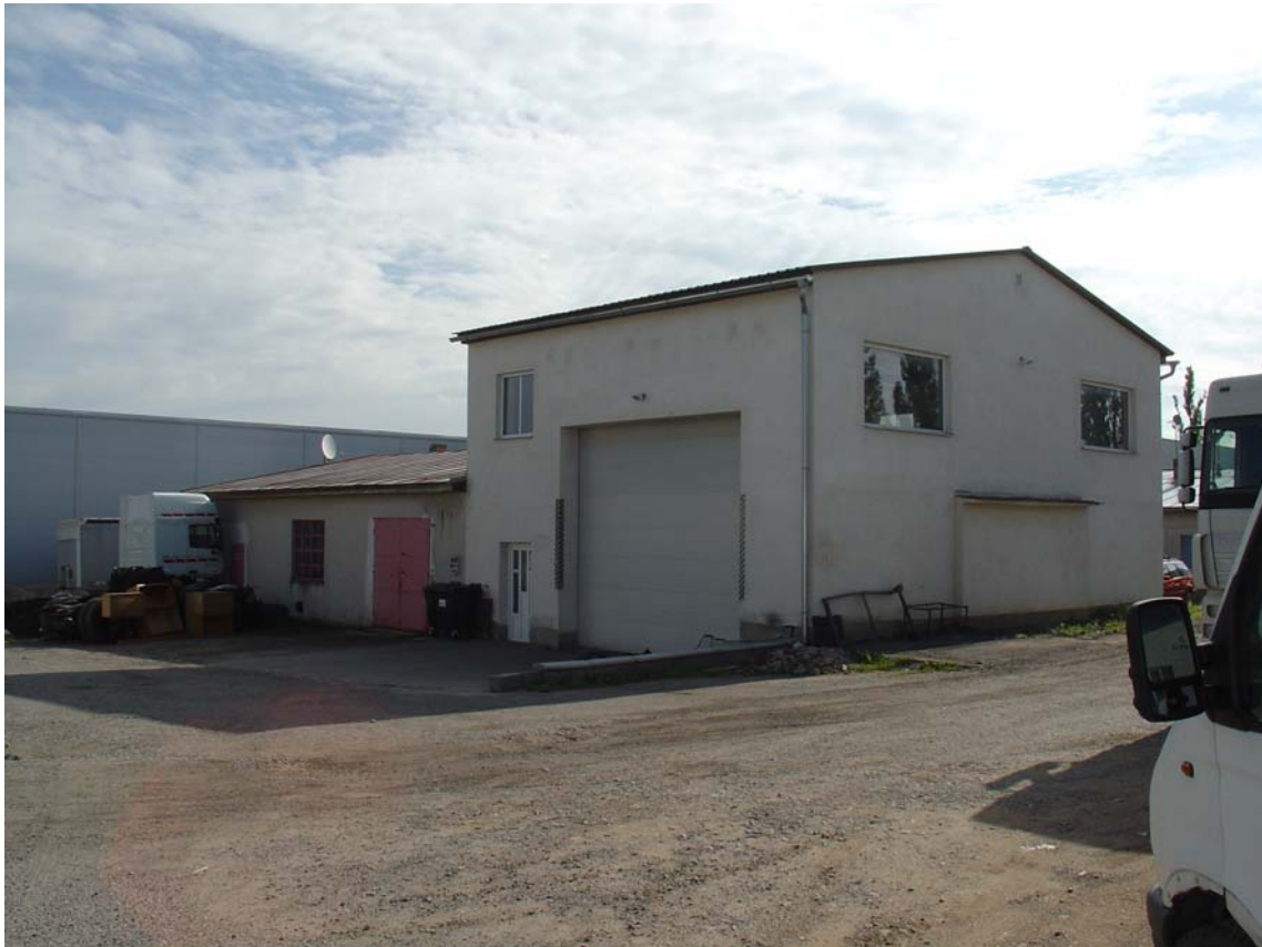
Foto 1 : Objekt dílny údržby a oprav motorových vozidel
