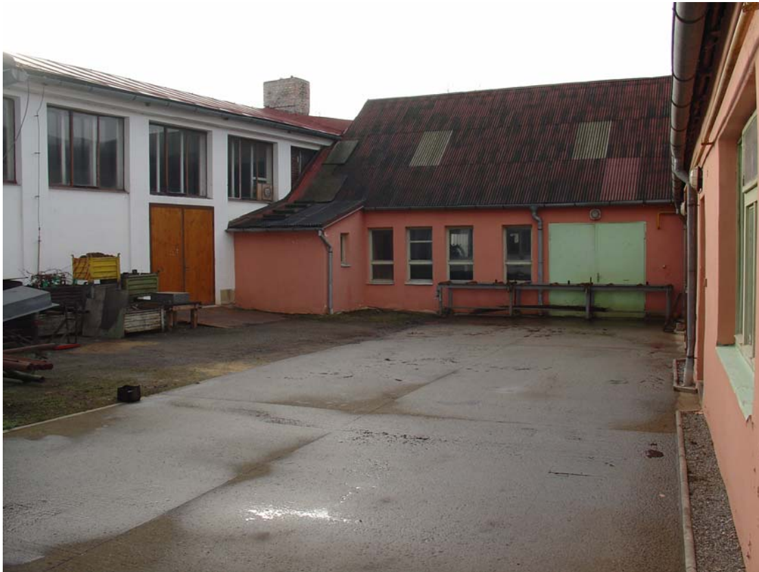
Foto 3 : Zadní část objektu při pohledu ze dvora
