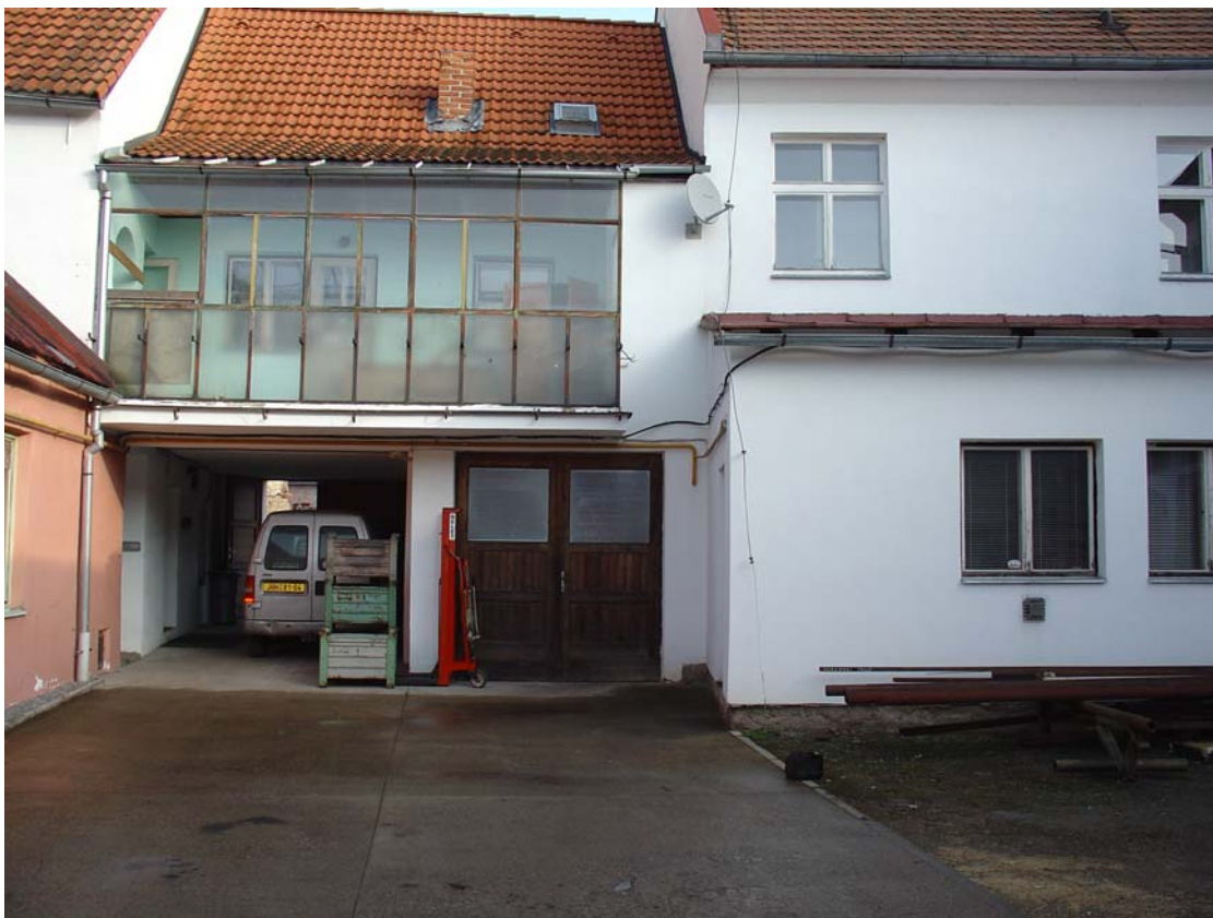
Foto 2 : Přední část objektu při pohledu ze dvora
