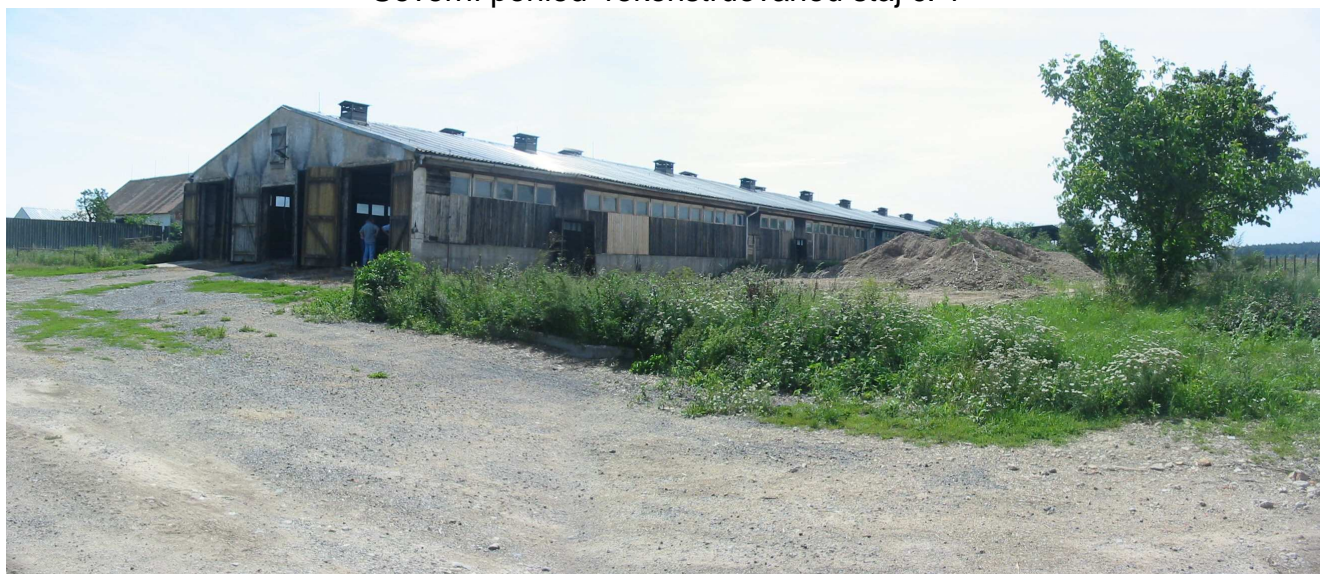
Severní pohled rekonstruovanou stáj č. 1
