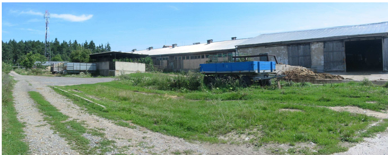
Západní pohled rekonstruovanou stáj č. 1
