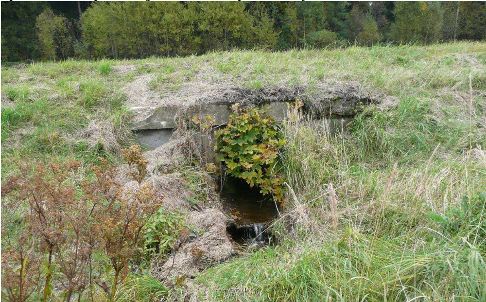
Obr. - Propustek DN 600 pod stávající silnicí I/34 – pohled na výtok
