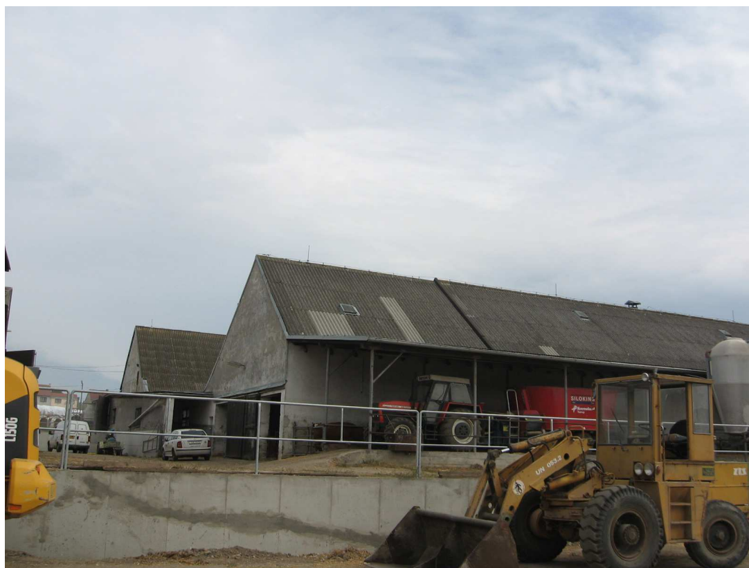
Pohled na stáje určené k demolici
