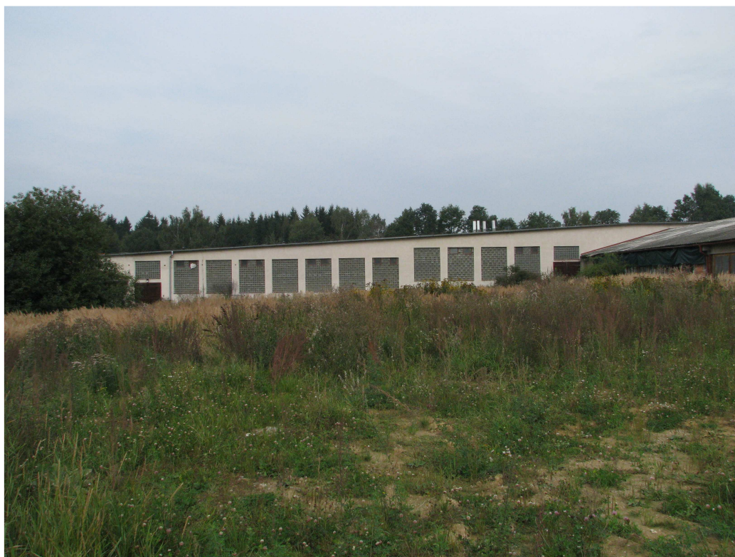
Pohled na místo stavby
