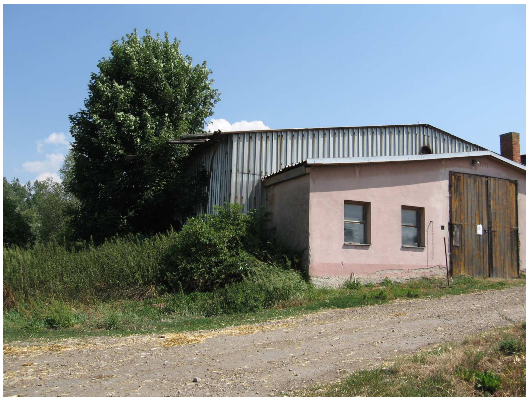
Sávající sklad určený k přestavbě na stáj
