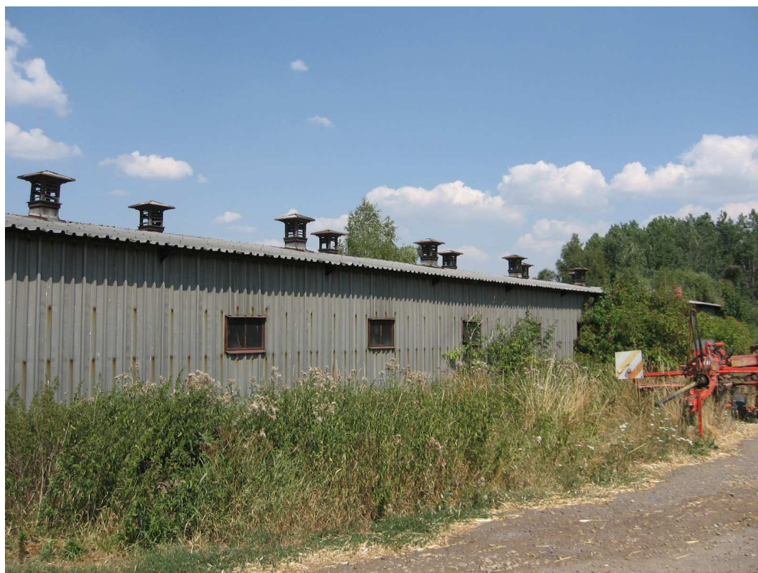
Sávající sklad určený k přestavbě na stáj
