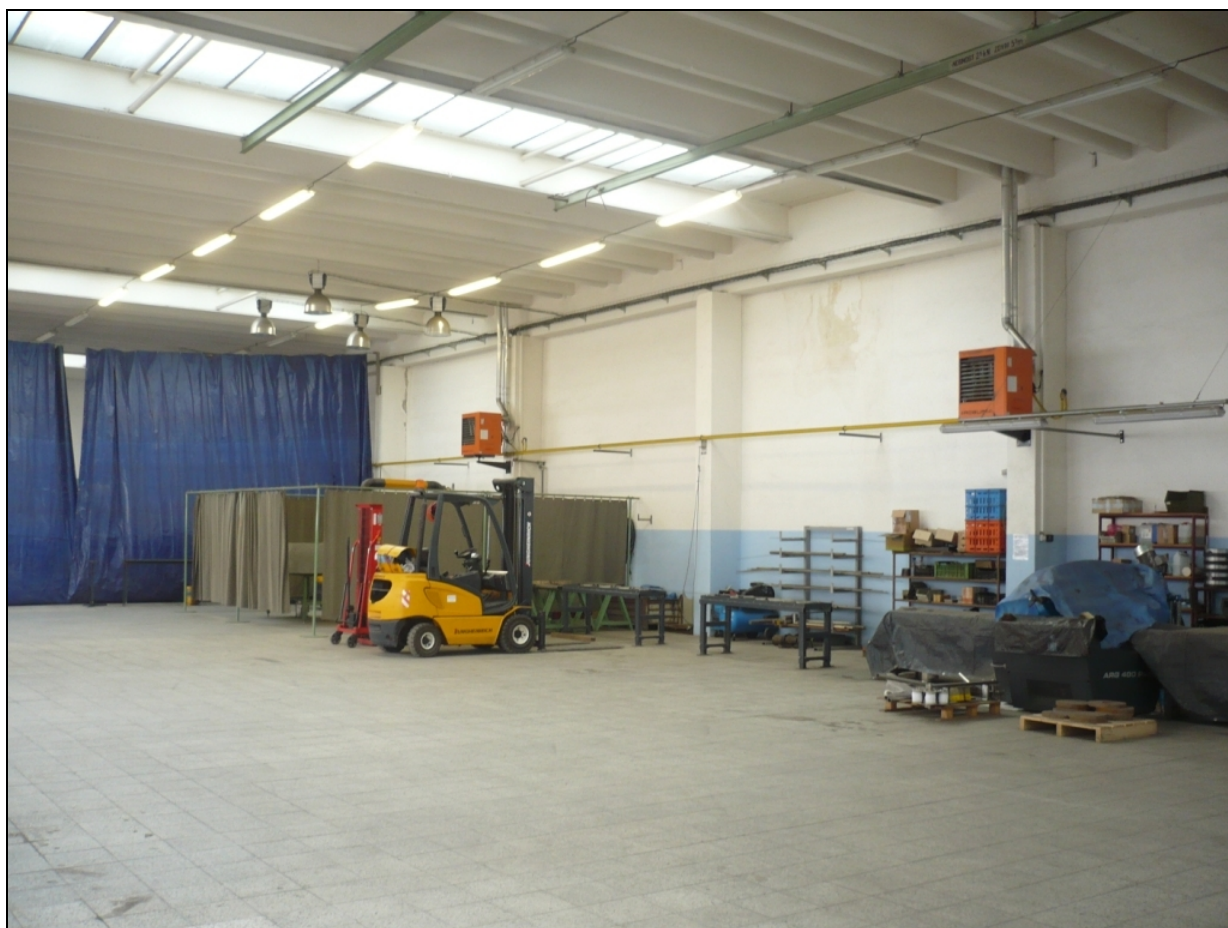
Obr. 3: Interiér haly pro umístění nového pracoviště pro nanášení práškových plastů, a.s. (foto autor)
