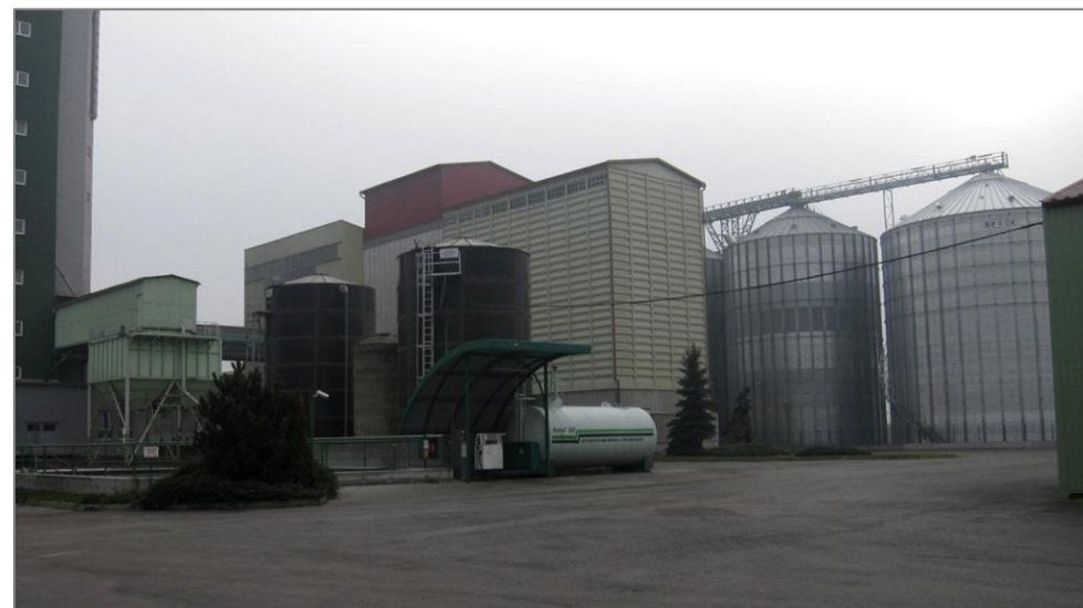
Foto 3: Pohled na stávající nádrže KMH. V popředí snímku příjezdová komunikace, bencalor a požární nádrž.
