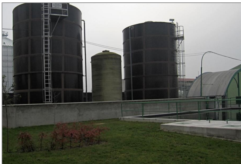
Foto 2: Pohled na stávající skladové nádrže KMH umístěné v havarijní jímce, v pravé dolní části snímku požární nádrž.
