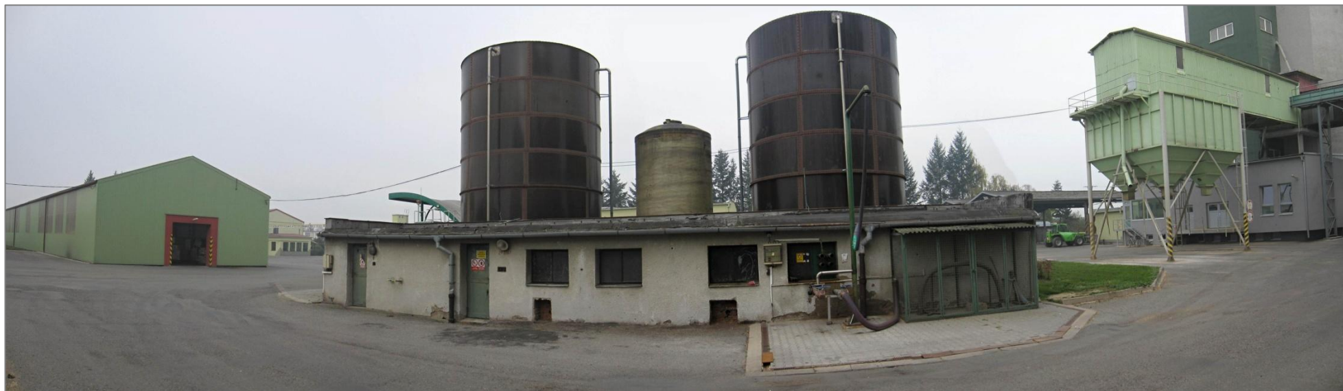
Foto 1: Celkový pohled na stávající nádrže KMH (pohled z J na S). V popředí výdejní plocha KHM, dále objekt tukového hospodářství, který bude odstraněn, a stávající skladové nádrže.
