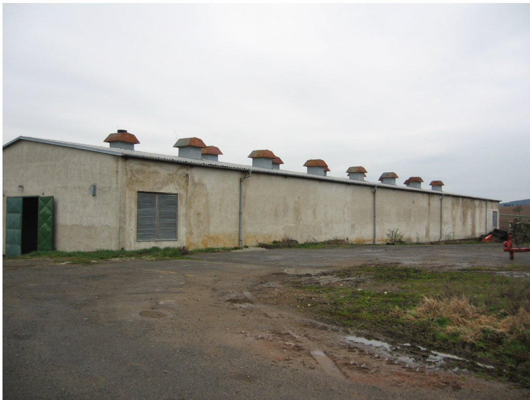
Bramborárna určená k přestavbě
