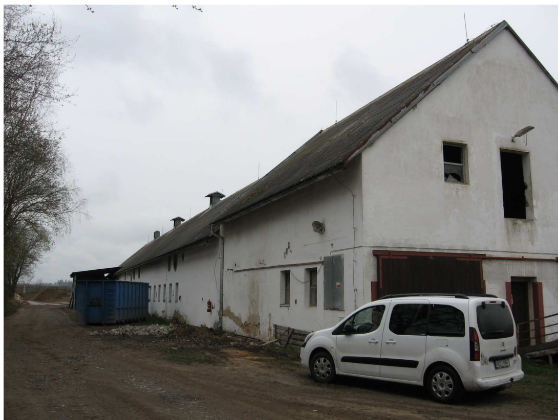
Stáj určená k rekonstrukci
