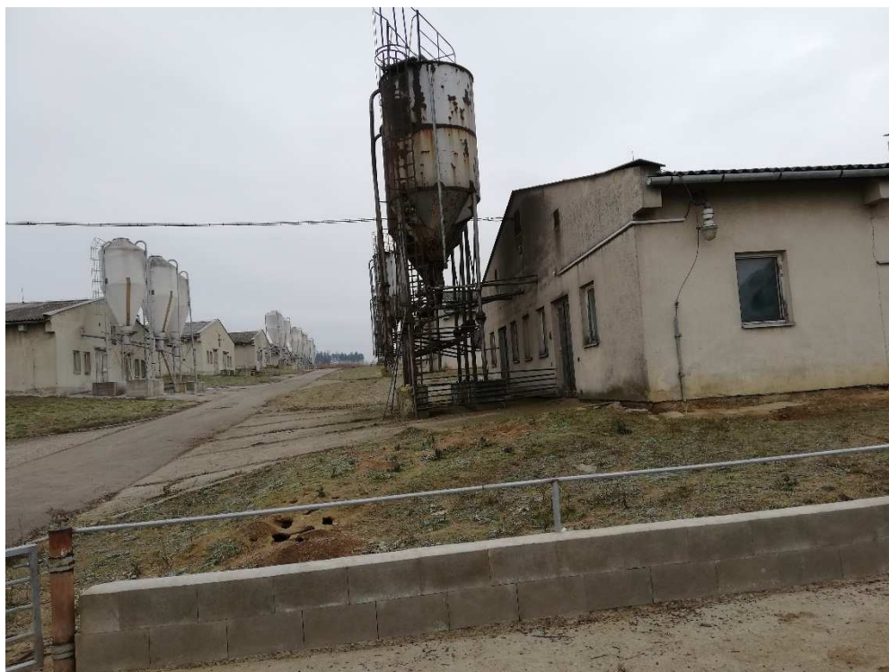
Pohled do areálu vpravo stáj určená k demolici
