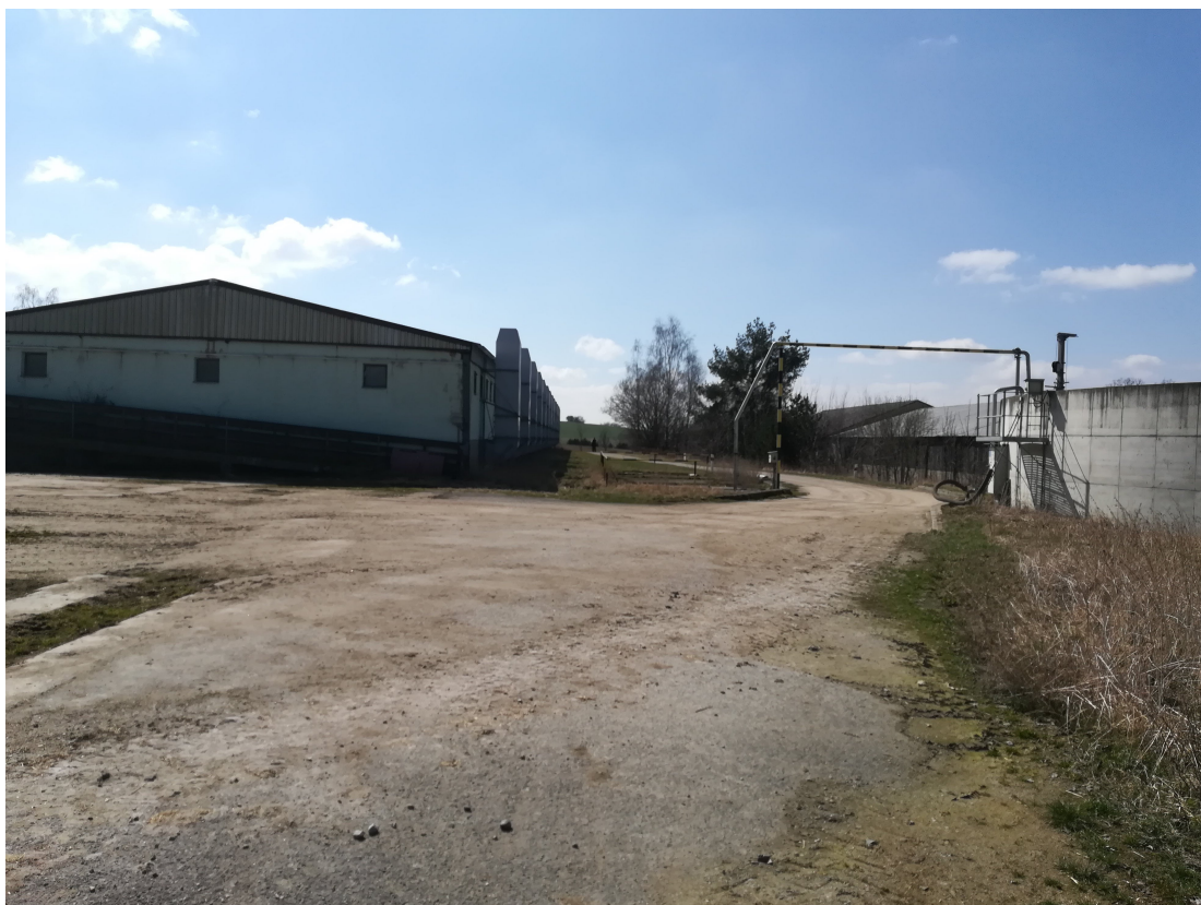
Severní pohled od jímky na stávající stáj
