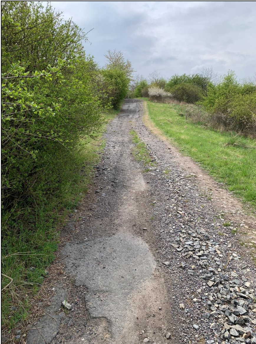
Obr. 30: Stávající hlavní příjezdová komunikace, která bude dle projektu upravena a zpevněna (04/2022).
