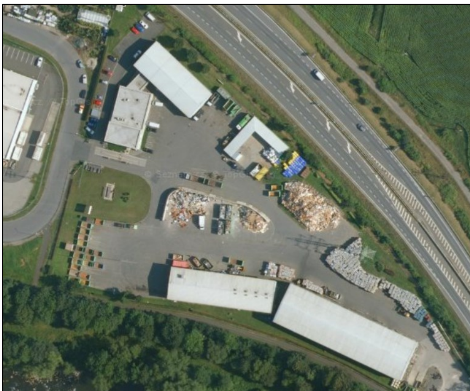
Obrázek 16: Zpevněné plochy v areálu Technických služeb
