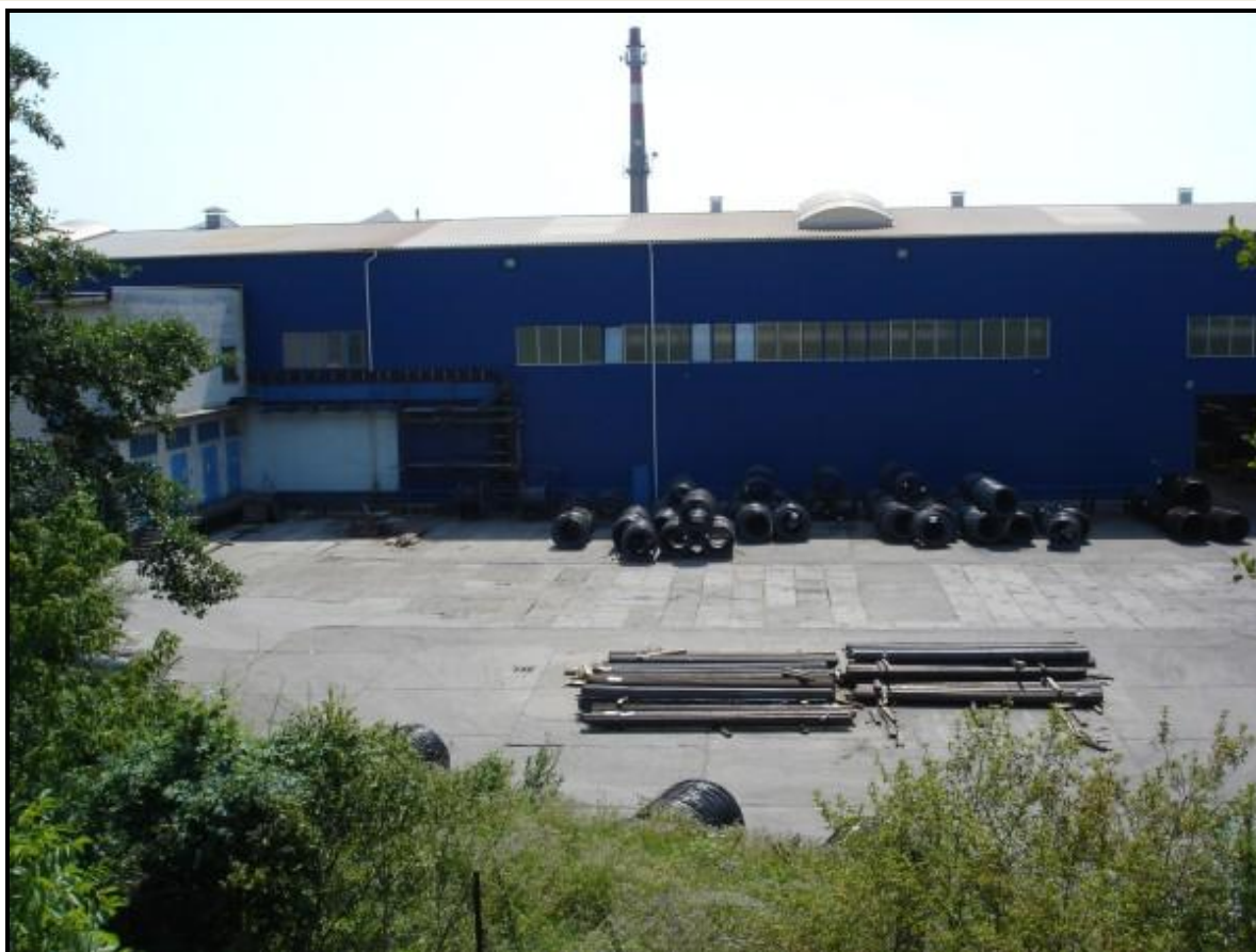
Obr.č.3 Pohled na místo výstavby haly F1, v pozadí hala E1
