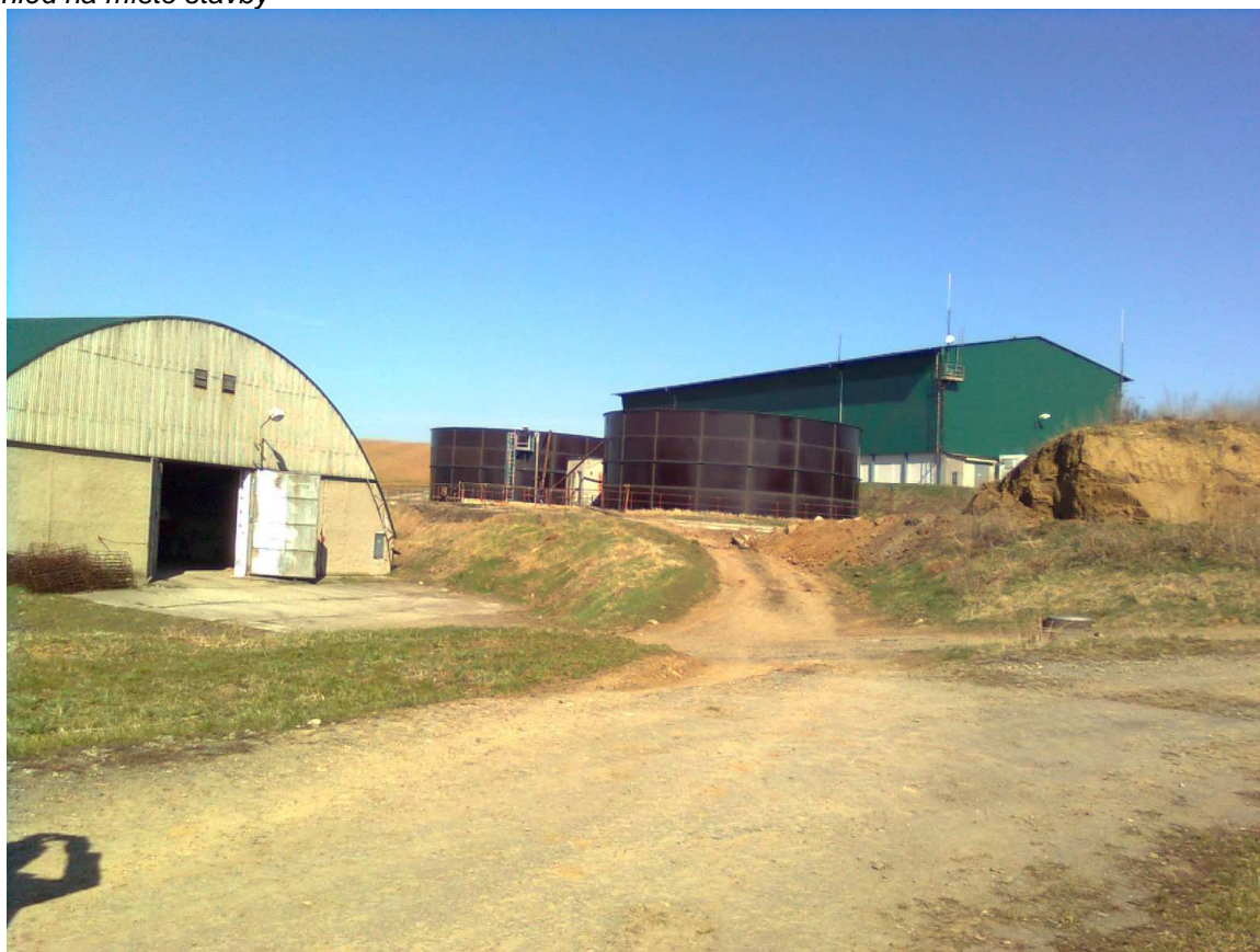
Pohled na místo stavby
