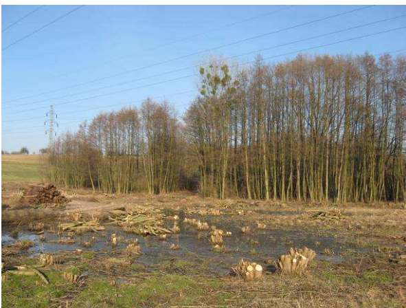
Obrázek 3: Kácení porostu pro výstavbu elektrického vedení v blízkosti záměru.
