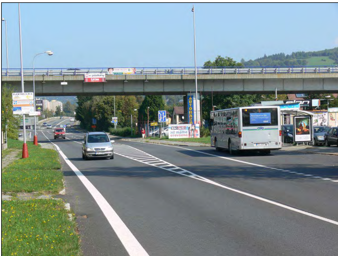
Obrázek 1: Místo budoucí okružní křižovatky na stávající silnici I/69
