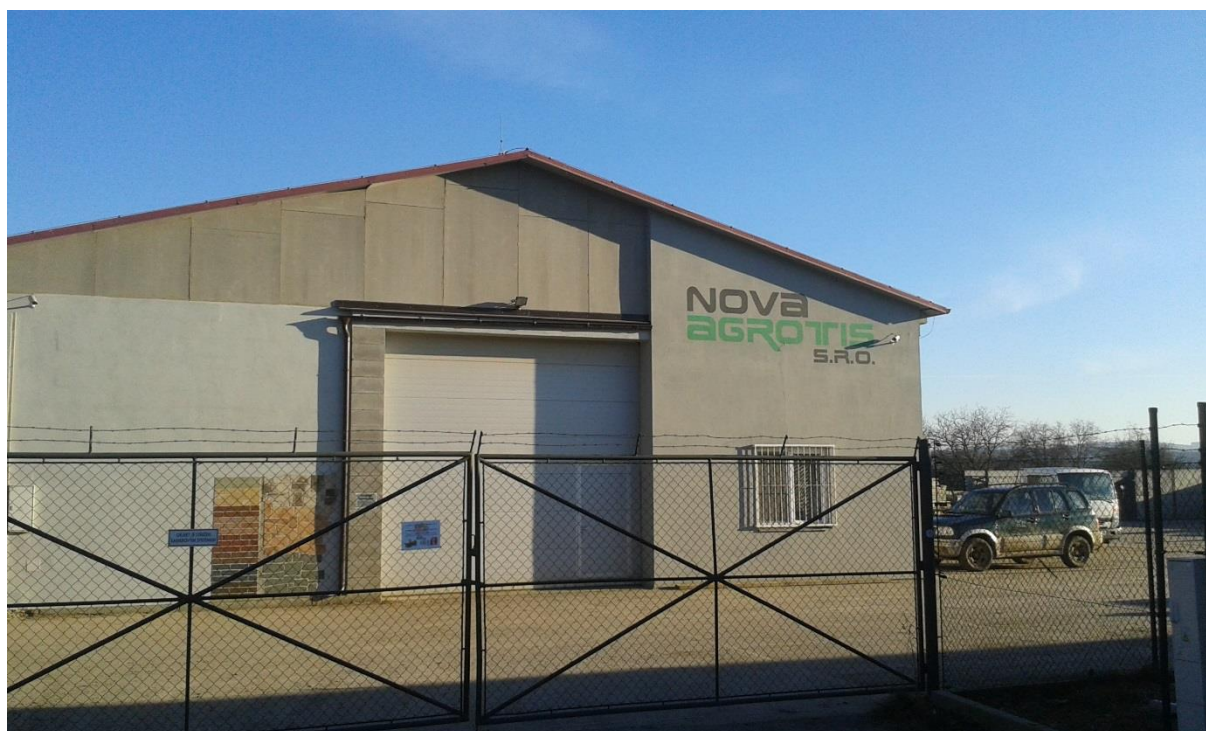
Obrázek 3: Pohled na stávající budovu v areálu firmy Novaagrotis s.r.o. ve Fryštáku, před kterou bude umístěna budoucí čerpací stanice pohonných hmot
