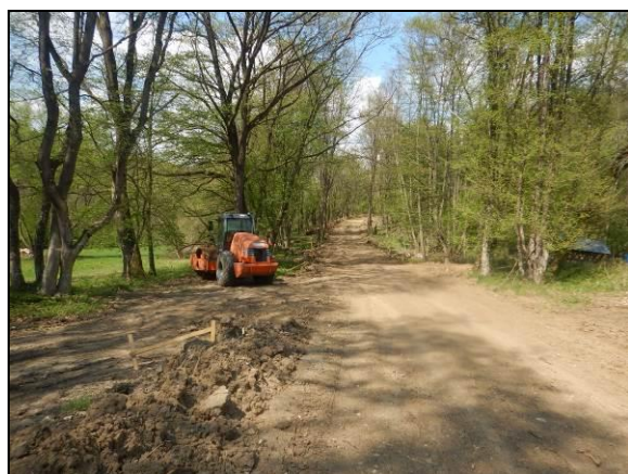
Budování cyklostezky přes lesní porosty nad EVL Ovčírka.
