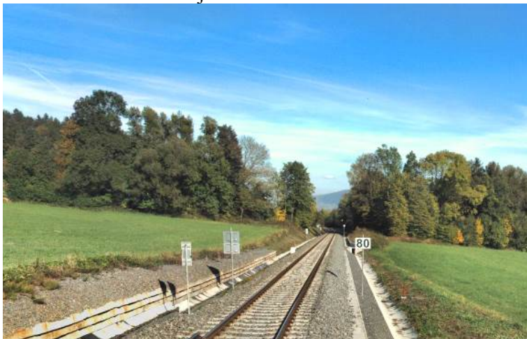
Foto 1: Pohled na stávající železniční trať v rámci koridoru DZ19.
