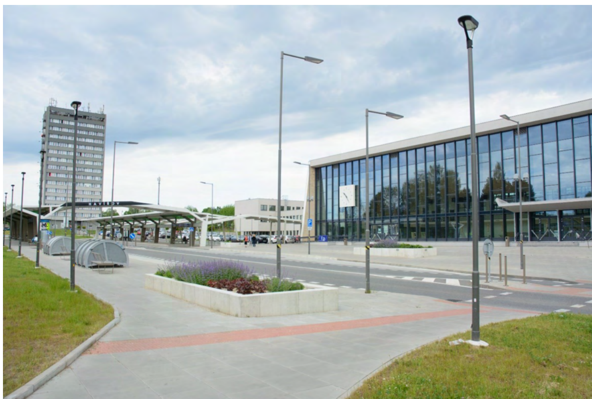
Obr. 34: Nově zrekonstruovaná nádražní budova a přednádražní prostor. Pro dnešní účely naddimenzovanou odbavovací halu si město pronajímá a provozuje v ní např. horolezeckou stěnu. Zdroj: ASITIS.
