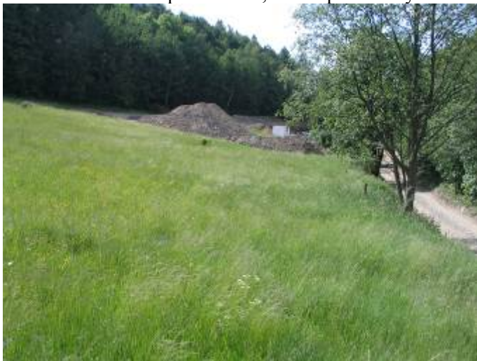
Foto 55: Pohled na plochu Z26, na níž probíhá výstavba a okraj plochy Z27.
