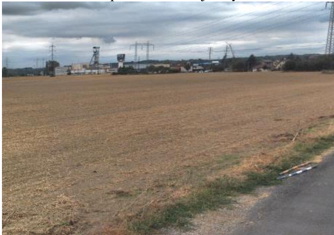
Foto 2: Pohled na plochu Z3/1 od jihovýchodu.
