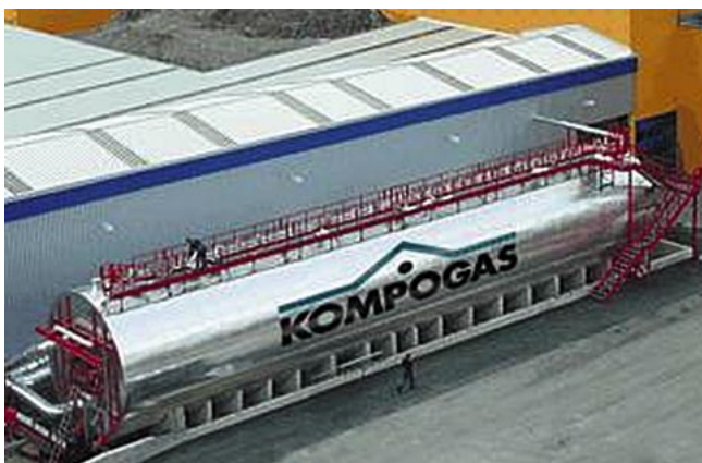
Obr.95: Uzavřený fermentor Kompostogas
