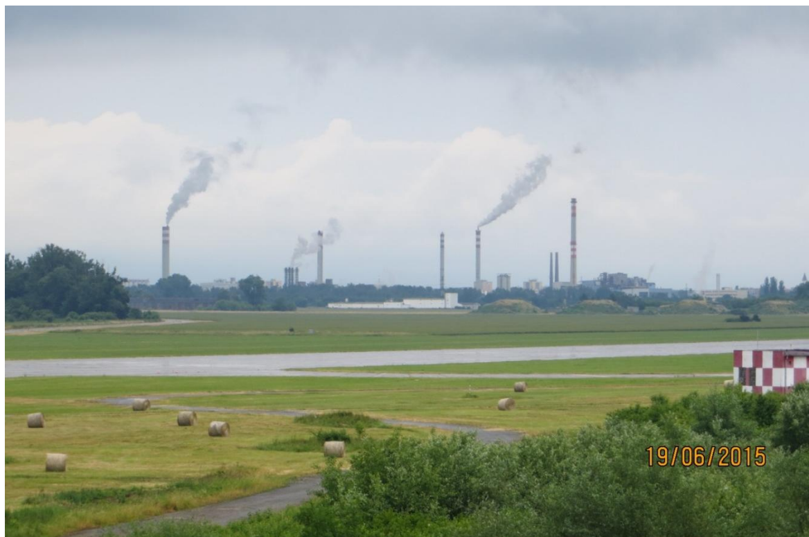
Obr. 33 Pohled na zájmové území od jihovýchodu
