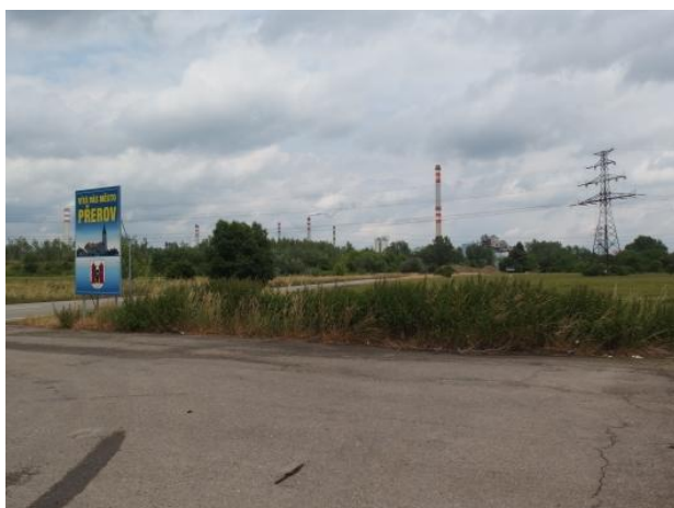
Obr. 9: Vedení VVN procházející po severním okraji řešeného území, v pozadí areály Teplárny Přerov a Prechezy
