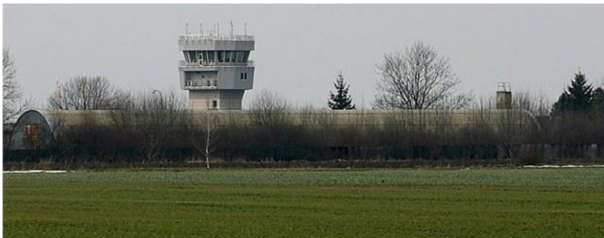
Obr. 12: Řídicí věž letiště - pohled od jihovýchodu
