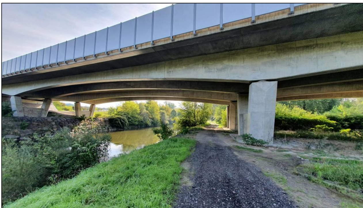
Fotografie 3: Stávající těleso dálnice D1 při průchodu přes řeku Olši a navazující částí nivy – migrační prostupnost je zajištěna (Autor: Marek Banaš)
