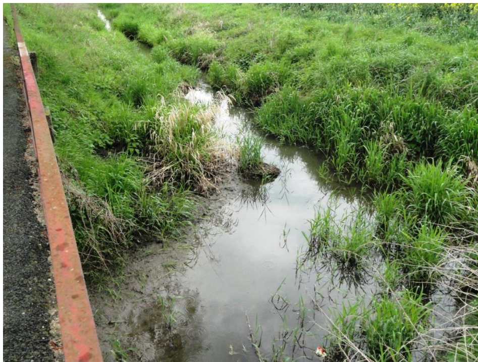
Koryto Třesického potoka v místě průchodu pod silnicí I/11
