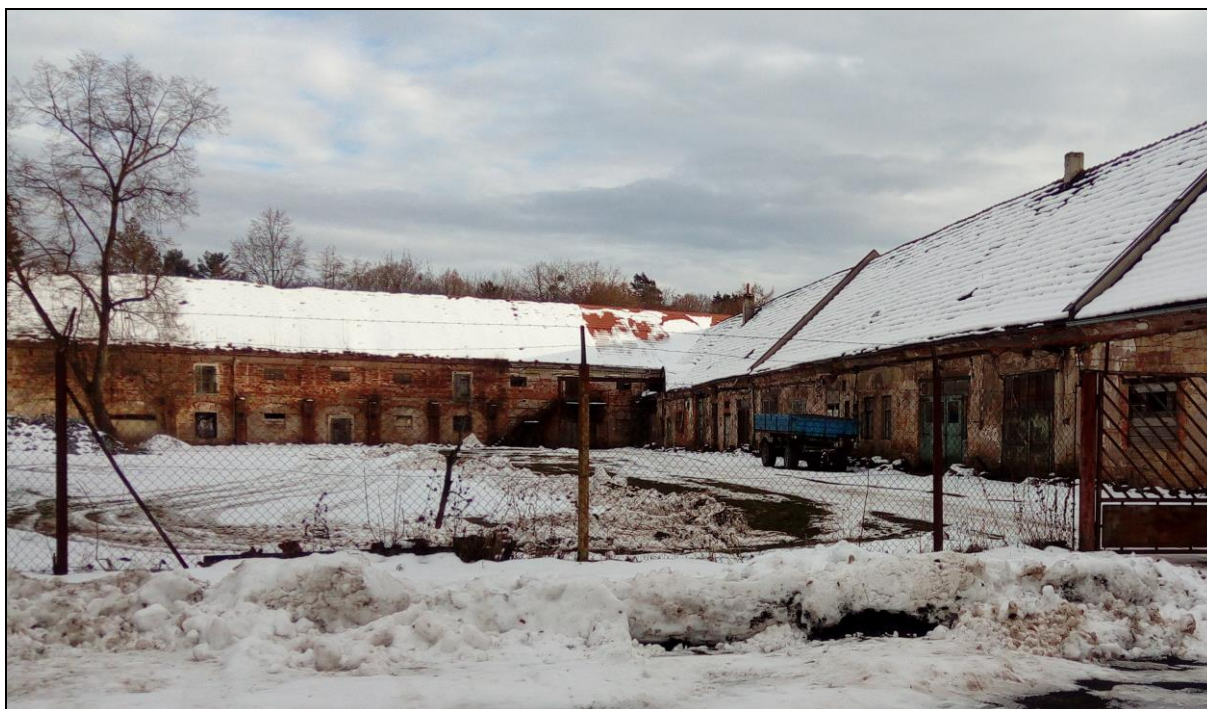
Obr. 4.9: Stávající stav budov k rekonstrukci
