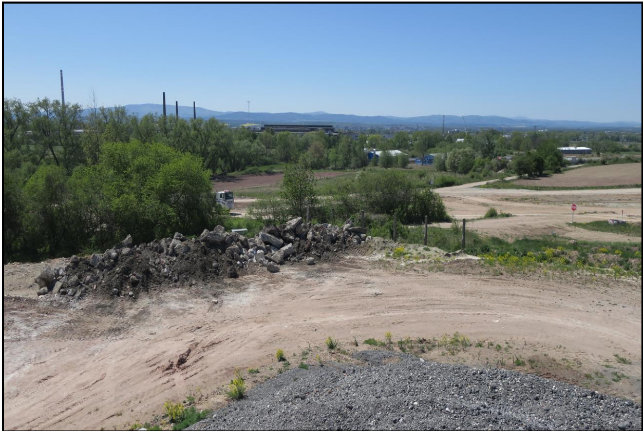
Obr. č. 8: V západní části k.ú. řešeného území - zahrnutého do rozvojové oblasti OB 10 České Budějovice - probíhají rozsáhlé terénní úpravy v souvislosti s výstavbou D3 a dalších ploch pro výrobu, skladování a komerci (v pozadí tovární komíny bývalé „Škodovky“).
