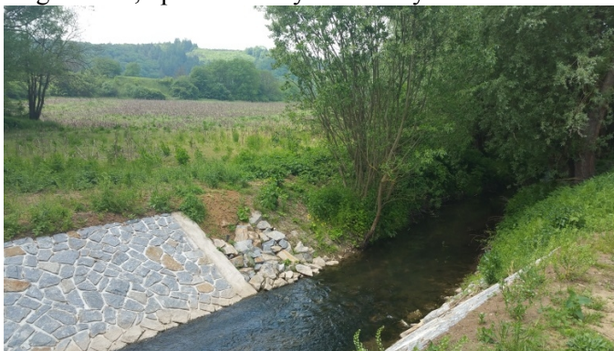
Foto 23: Pohled na plochu N13 ze stávající komunikace, v popředí snímku je patrné zregulované, opevněné koryto Bobravy.
