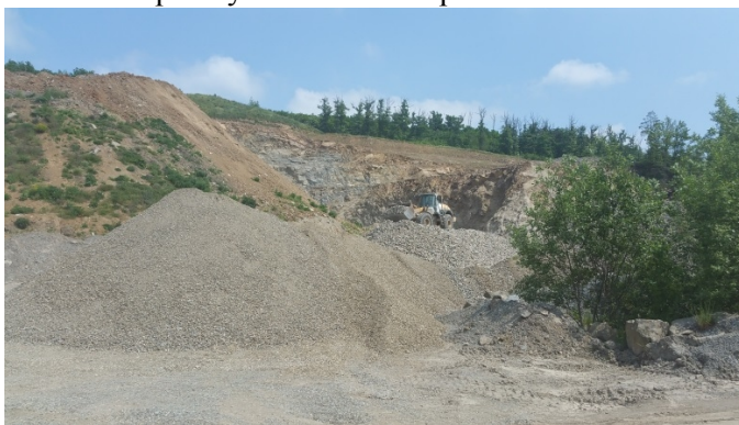
Foto 31: Pohled na střední část plochy P21, na etážích v pozadí fotografie by měl v rámci rekultivace plochy vzniknout lesopark.
