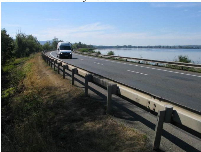
Foto 3: Pohled na stávající trasu I/52 od severu.
