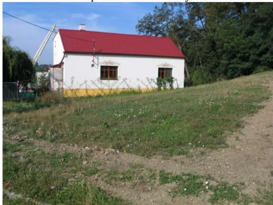
Foto 8: Pohled na plochu Oe3 ze stávající komunikace.
