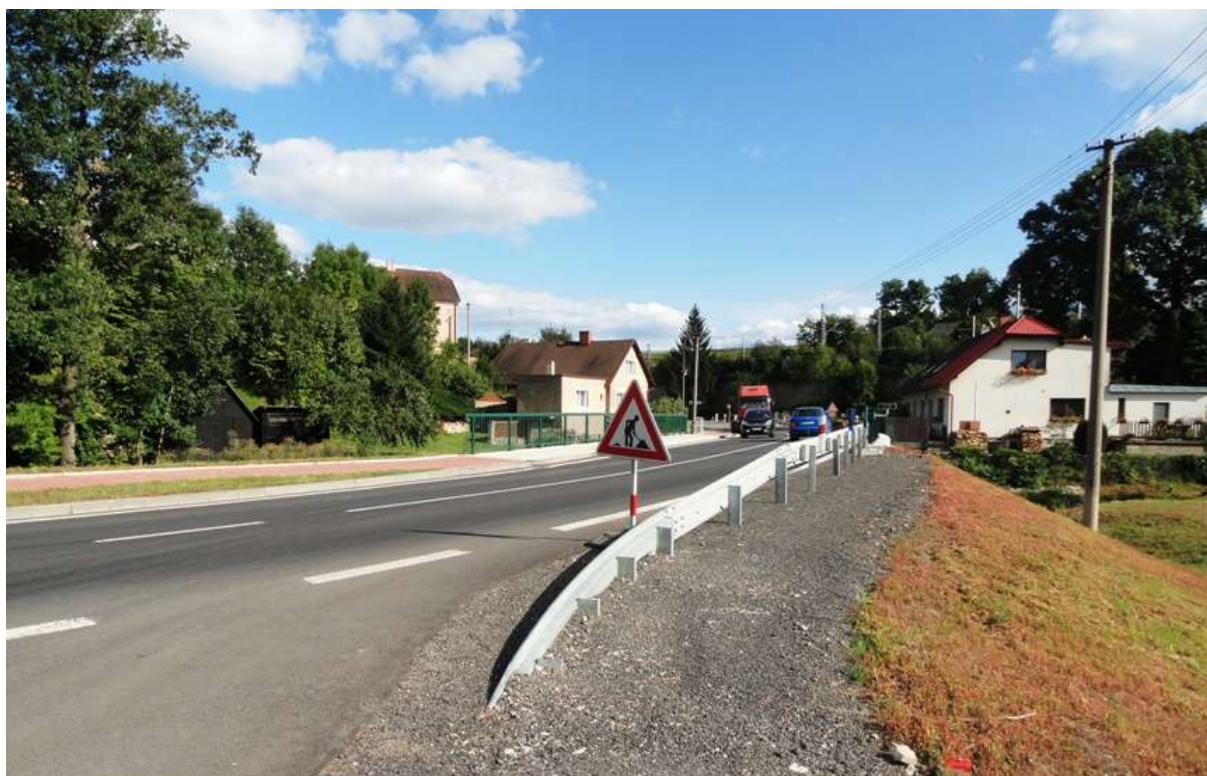
Obrázek 14: Foto 8: Most přes Třebovku na I/14 v centru obce.
