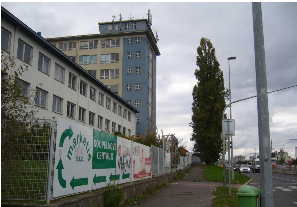
4. Boční pohled na budovy areálu (od ulice Poděbradská – v pravé části obrázku). Pohled ve směru jihozápad.
