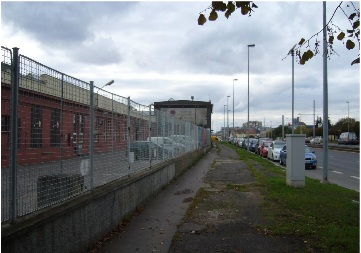
7. Budovy v areálu firmy Tesla a.s. ve směru západ. Pohled z ulice Poděbradská.
