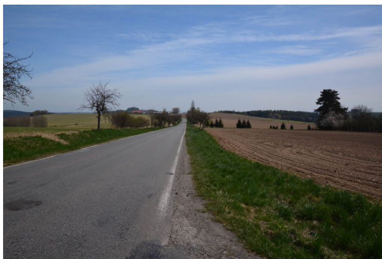
Silnice II/111 vede většinou po návrší resp. rozvodnici a tvoří předěl mezi dvěma krajinnými prostory.
