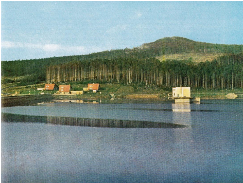
Obrázek 31: Vodárenská přehrada Přísečnice, stav v r.1984
