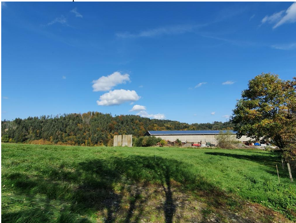
Foto 20: Pohled na plochu VZ 281 z místní komunikace.
